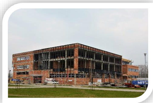
1 pav. KU laboratorijų pastatas statybų metu
